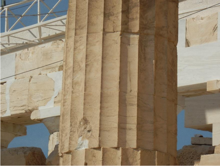
Dettaglio colonna lato Sud
